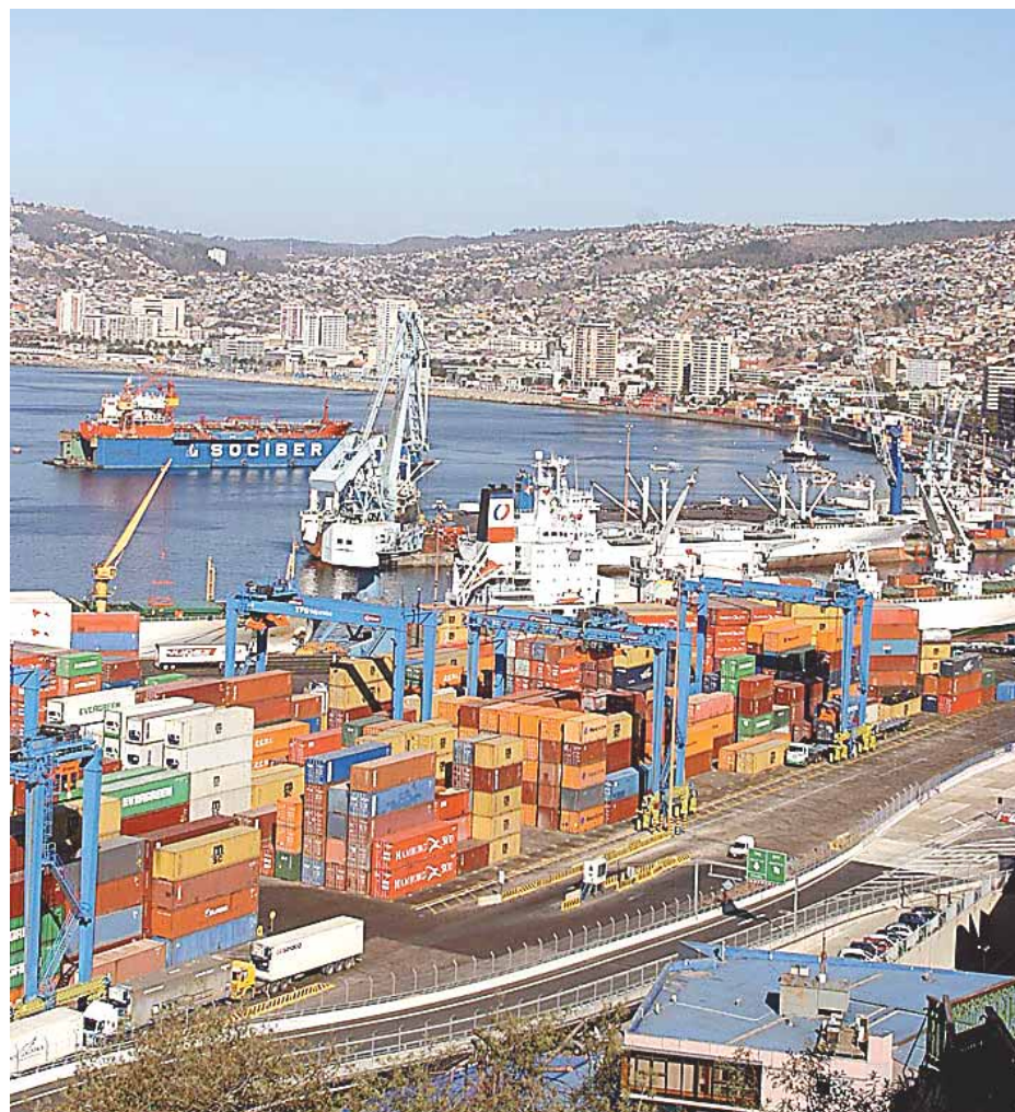
La estatal explica que resulta trascendental que Valparaíso "aumente su capacidad de transferencia cuanto antes".
